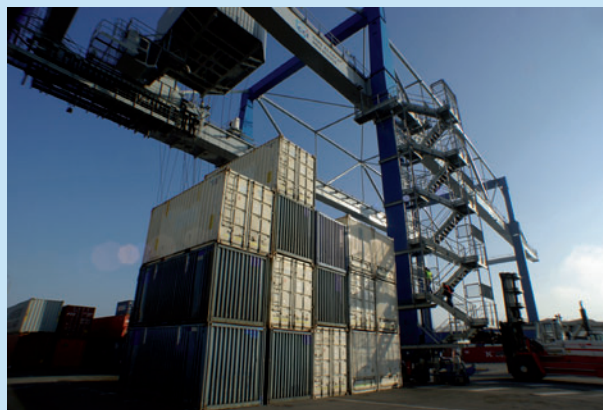
Photo : Terminal d'Ottmarsheim / CCI Mulhouse Sud Alsace
